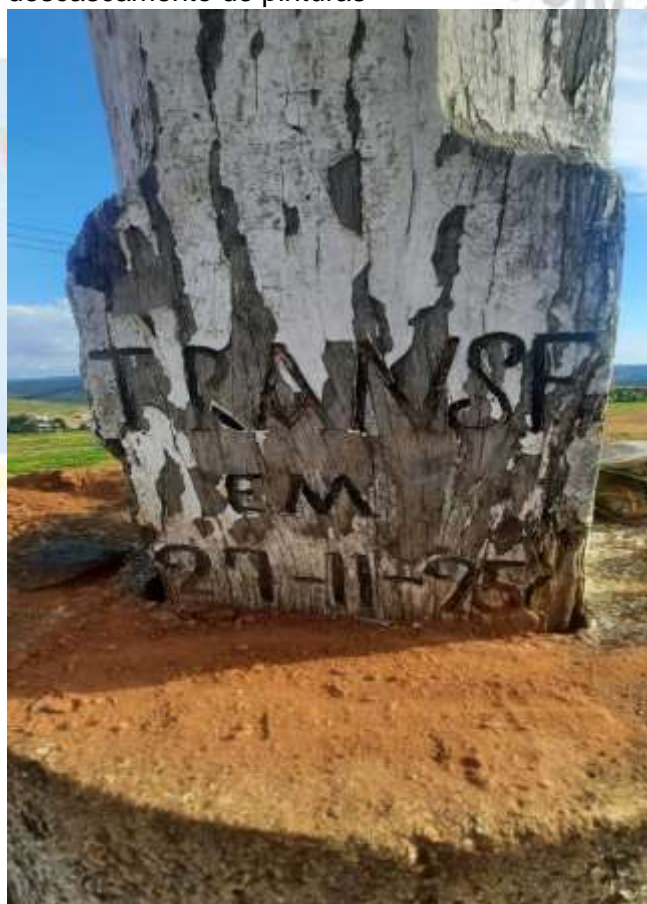
Imagem 5: Desprendimento e descascamento de pinturas
