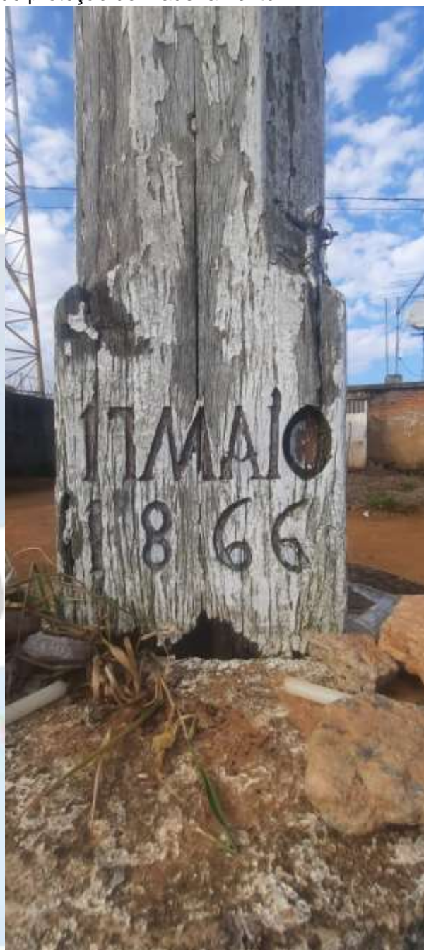
Imagem 6: Perda da camada de proteção do madeiramento
