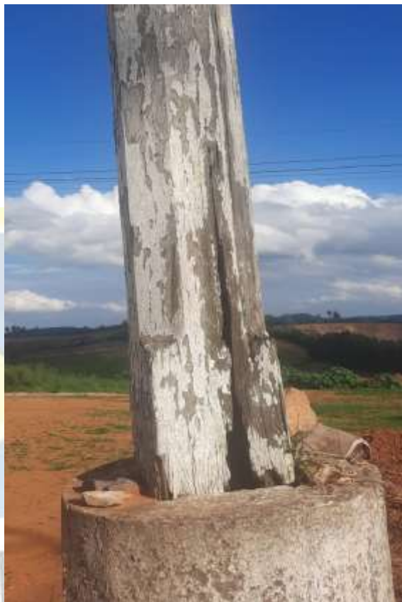
Imagem 5: Desprendimento e descascamento de pinturas
